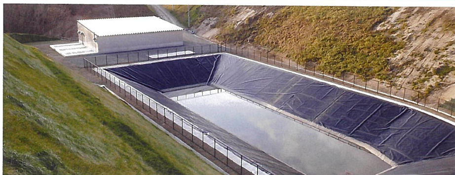
浸出水処理施設と浸出水調整池
